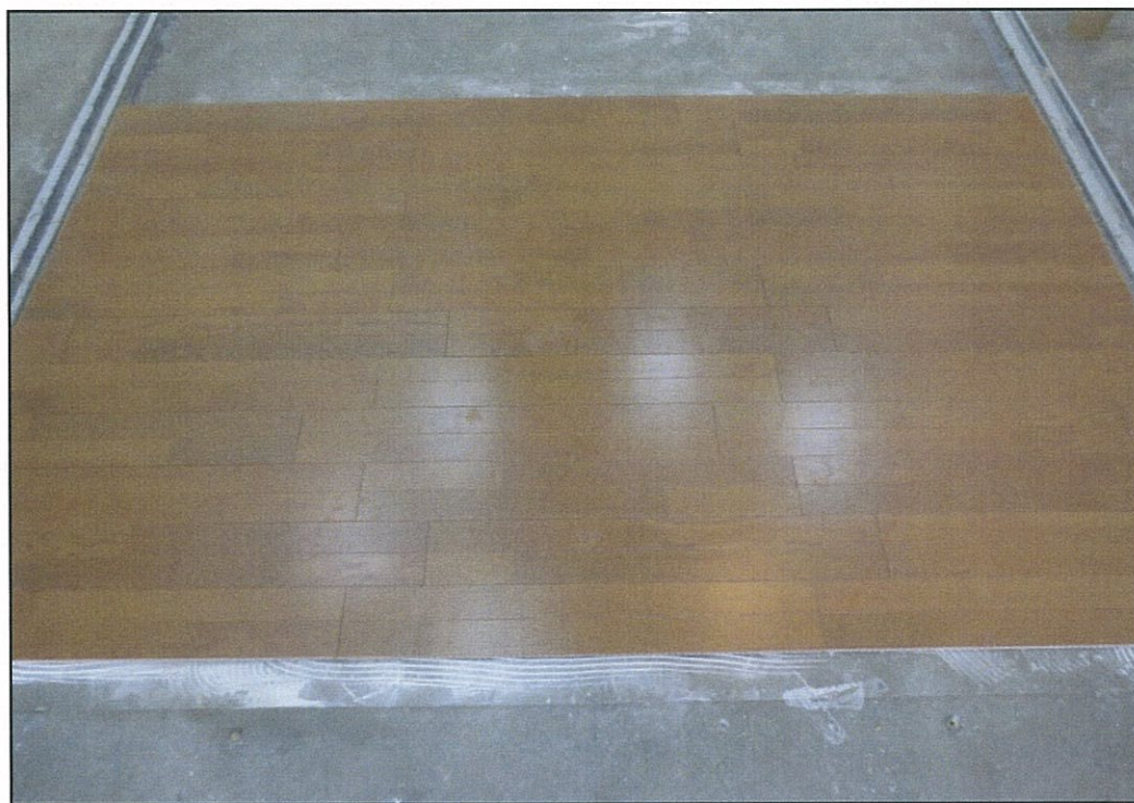
写真1 試験体の外観
